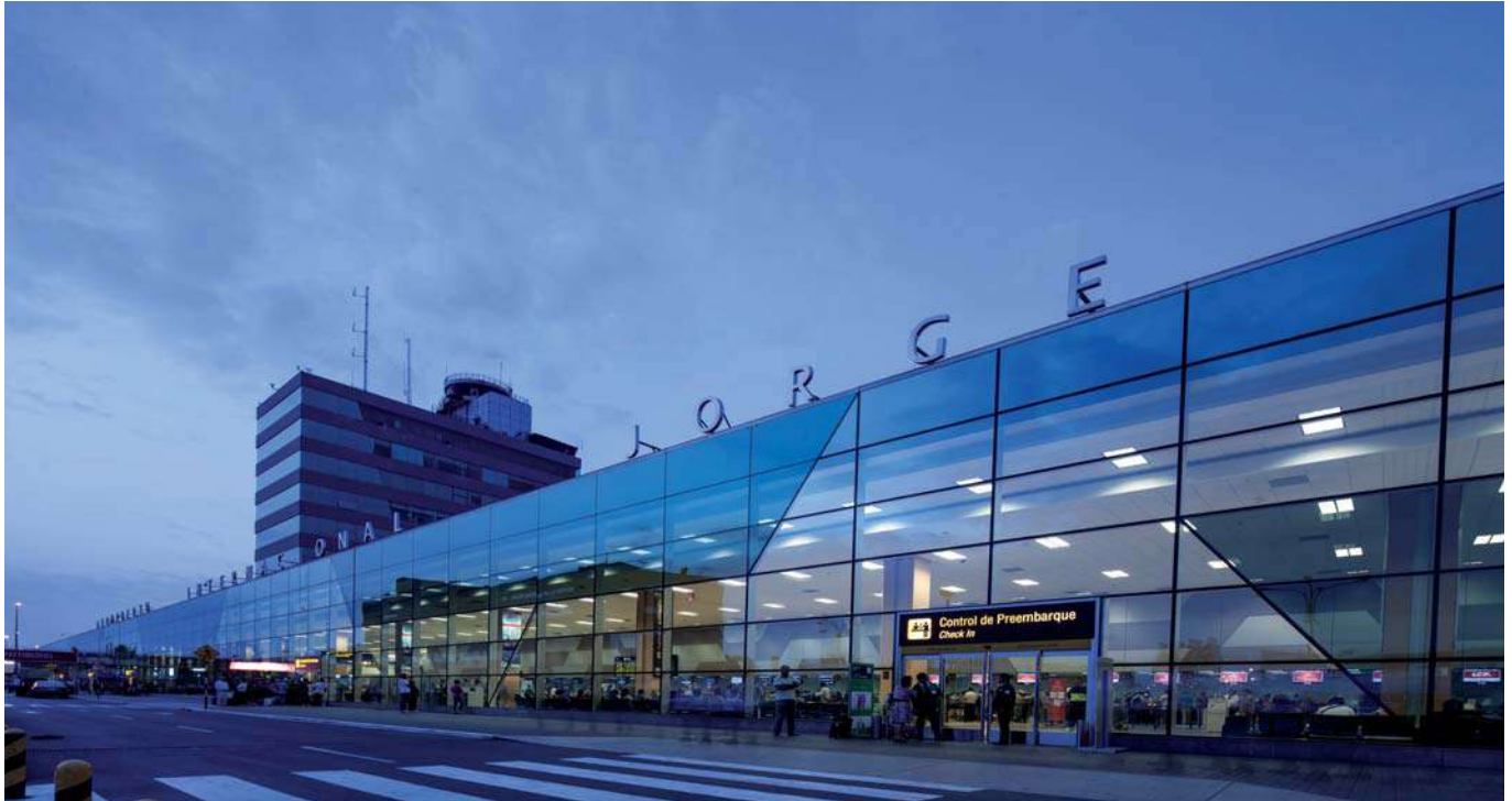
AEROPUERTO JORGE CHÁVEZ, NUEVO TERMINAL DE PASAJEROS PARA VUELOS INTERNACIONALES, Y 2 PISTA DE ATERRIZAJE (3,500 M). CALLAO.
