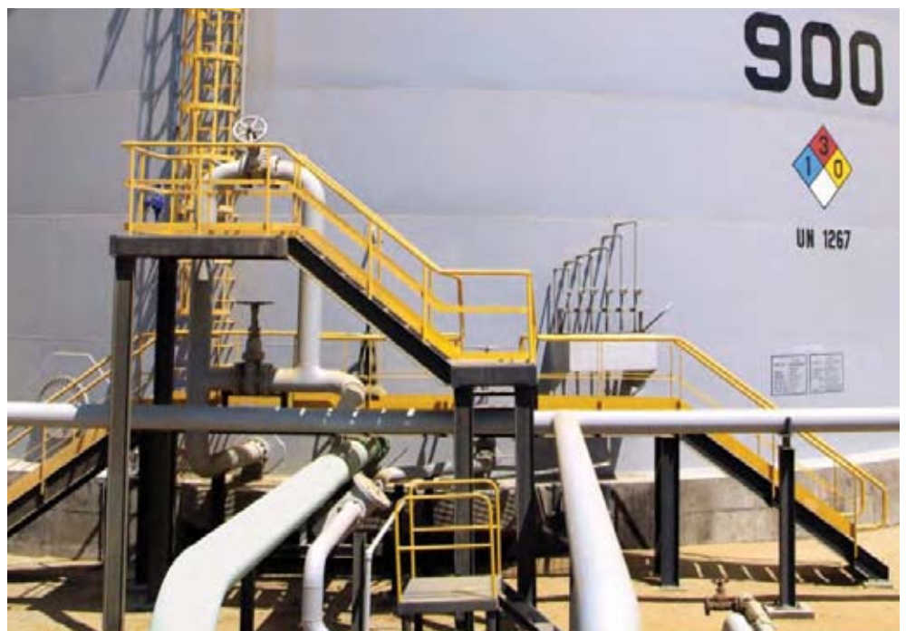
Planta de tratamiento de agua de lastre. Refinería de Talara. Treatment plant for ballast water. Talara refinery.
