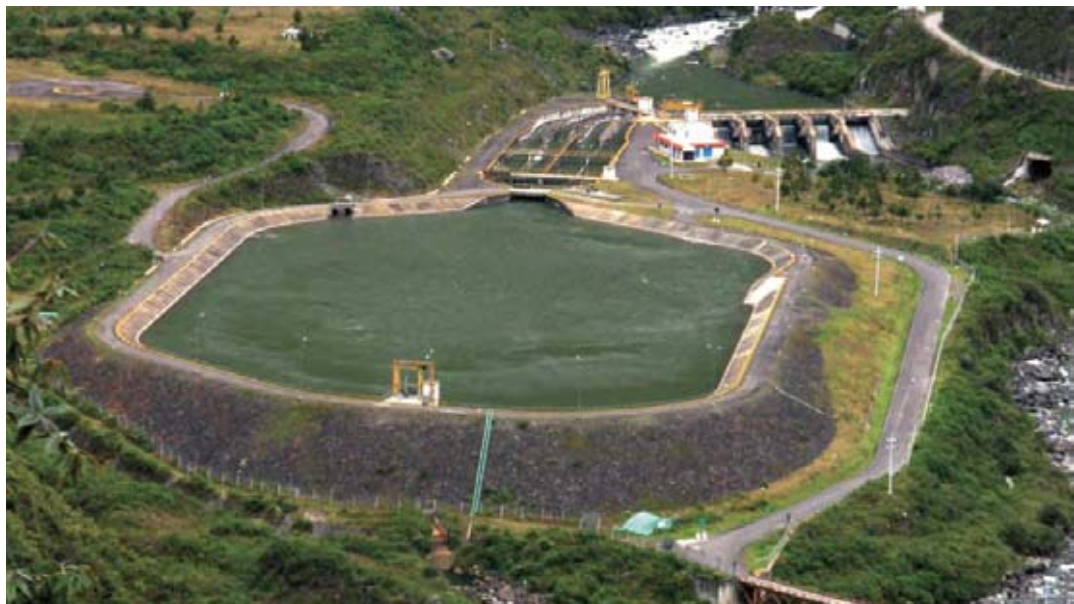
Obras de captación C.H. San Gabán II; 110 MW. San Gabán II 110 MW; hydroelectric plant. Headworks.
