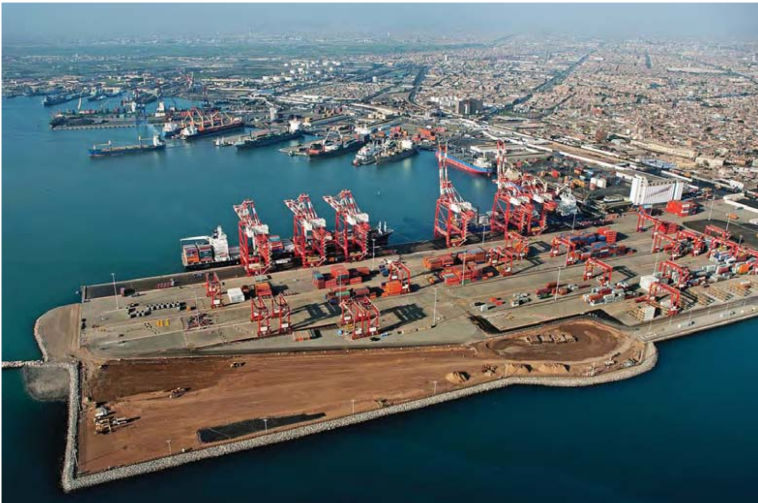
Nuevo terminal de contenedores del Puerto Callao, zona sur. New containers terminal of Callao Port, south zone.
