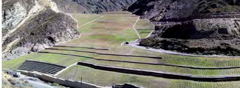
Depósito de relaves de Tablachaca. Concentradora Casapalca. Antes y después de la remediación. Tailings pond in Tablachaca. Casapalca concentrator plant. Before and after reclamation works.
