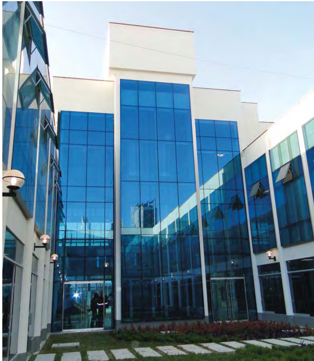
Nuevo Hospital Pisco. New Pisco hospital.
