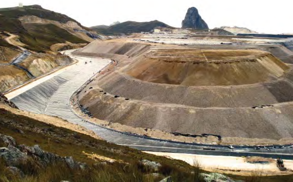
PAD de lixiviación (fase 2) Mina Lagunas Norte, Alto Chicama, Barrick. Control de calidad de movimiento de tierra y compactación.
