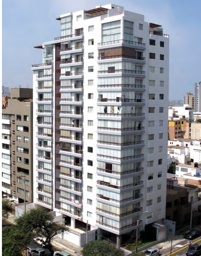
Edificio Alameda Pardo/Siena. Alameda Pardo building/Siena.
