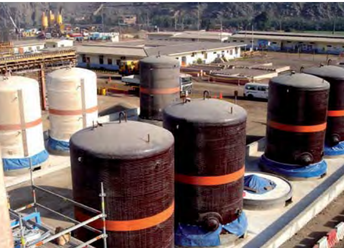
Tanques de cloruro férrico para coagulación. Planta de tratamiento de agua potable de Huachipa. Ferric chloride tanks for coagulation. Huachipa drinking water treatment plant.
