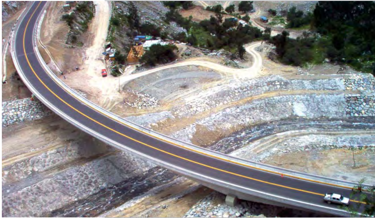
Puente Collana Carretera Héroes de la Breña. Collana bridge. Héroes de la Breña highway
