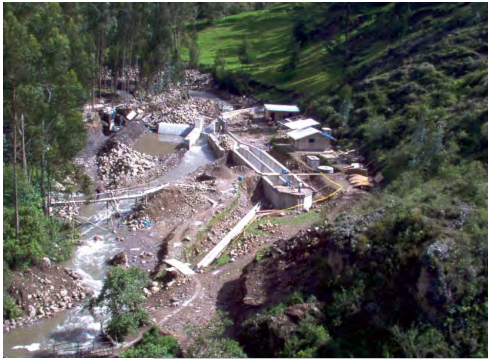
Captación Río Grande. Proyecto de Agua Potable y Alcantarillado de Cajamarca. Grande river intake works, for the water and sewerage project of Cajamarca.
