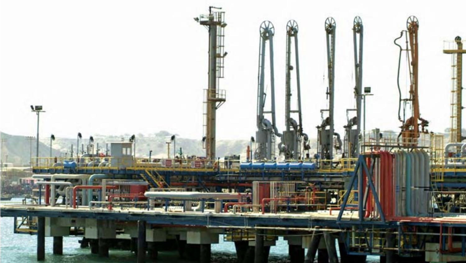
Muelle de Carga Líquida - Refinería de Talara. Liquid cargo dock. Talara refinery.
