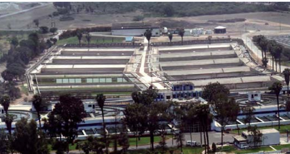
Planta de tratamiento de agua potable de La Atarjea. Estudio de mejoramiento y rehabilitación de la Planta N° 1.
