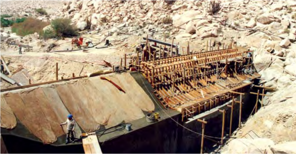
Presa Huayrondo. Huayrondo dam.
