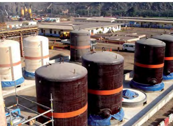
Tanques de cloruro férrico para coagulación. Planta de tratamiento de agua potable de Huachipa. Ferric chloride tanks for coagulation. Huachipa drinking water treatment plant.
