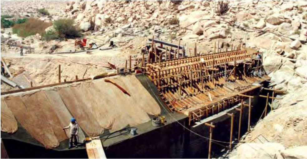
Presa Huayrondo. Huayrondo dam.
